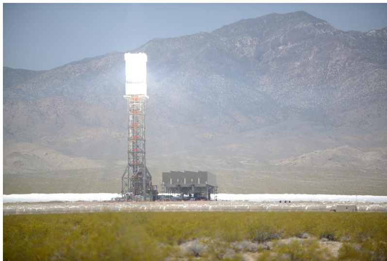
Figure III-5 : Tour d'énergie solaire.
