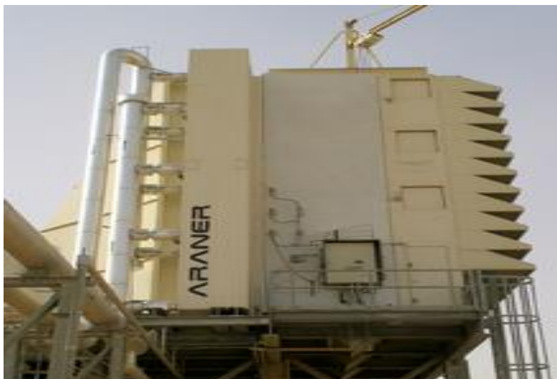
Figure I.2: Modification du filtre de refroidissement à air de la turbine pour placer le serpent de refroidissement provenant de l'installation de refroidissement par compression à l'ammoniac
