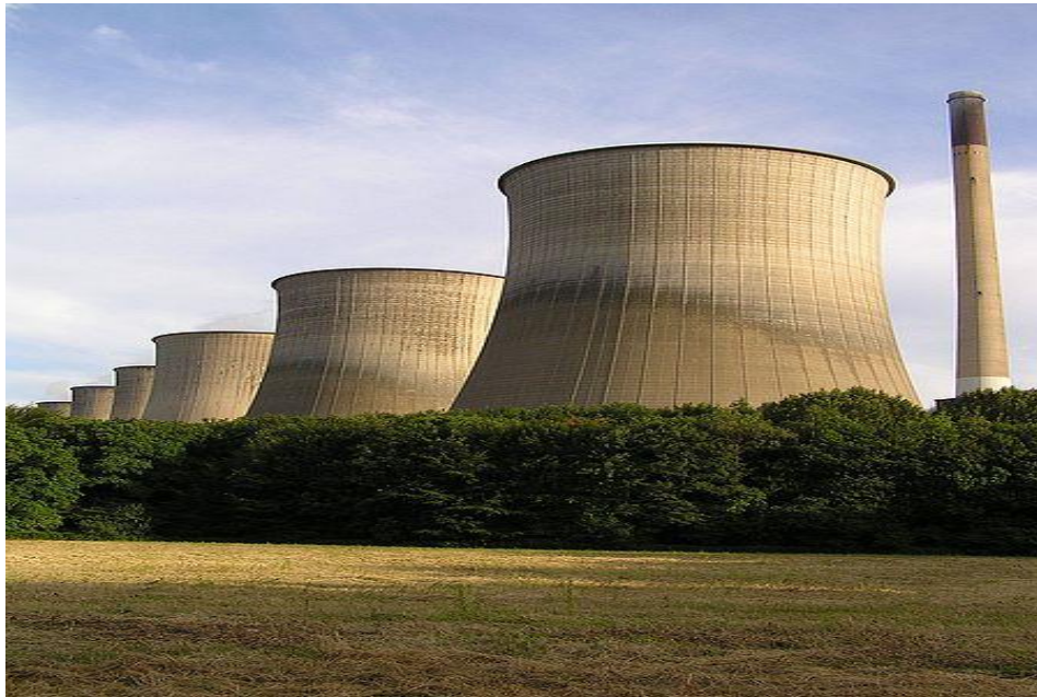
Figure II-4: Tours de refroidissement de la centrale thermique à charbon de Gelsenkirchen-Scholven
