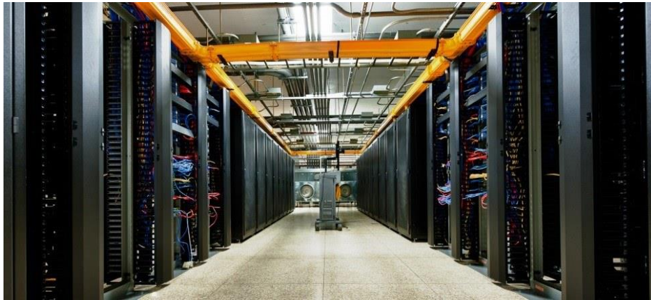
Figure I.5: Unités de refroidissement pour centres de données
