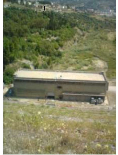
صورة رقم ( 04 ): محطة توليد الطاقة الكهربائية
