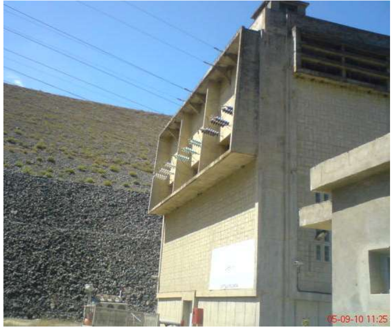
صورة رقم (10): مخرج الأسلاك الكهربائية
