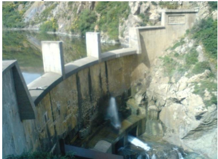
صورة رقم (15) حاجز سد شعبة الأخرى لإعادة تجميع المياه
