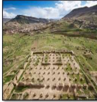
أطلال المسجد الذي تتكون غرفة الصلاة فيه من : 13 ثلاثة عشر رواقاً وثمانية فواصل و المنذنة
