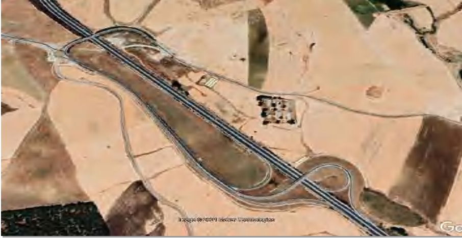
محول المريج (الخروب- قسنطينة)
