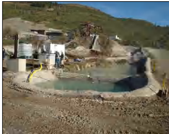
صورة رقم (17): حوض تجميعي لتصفية المياه الملوثة
