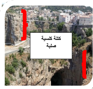
صورة رقم 02 تشكيلات كلسية صلبة - الصخرة- المصدر: أرشيف مديرية التعمير والبناء-2012
