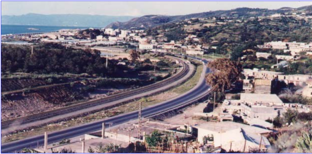
Photo n°1 : La ligne ferroviaire et la RN 43 traversant l'ACL
