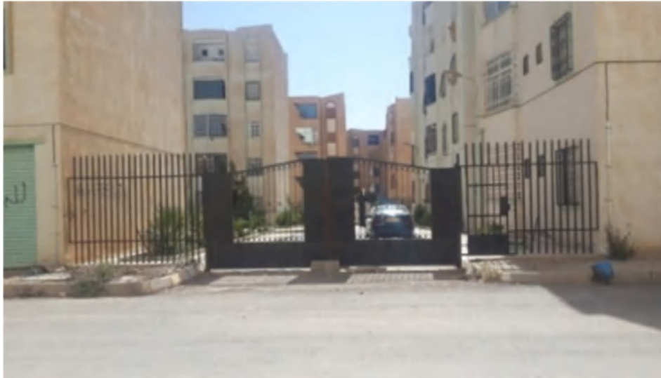
Figure 6-27: Des accès mécaniques condamnés (Ali Mendjeli Constantine 2020)
