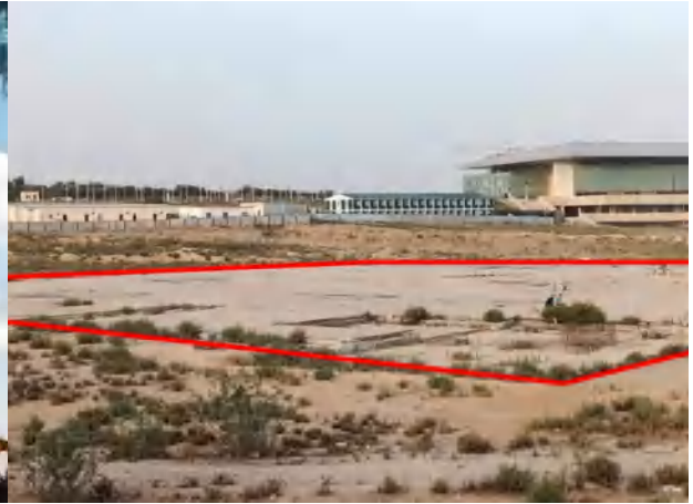
Figure 8-4: Palais des expositions Arrêt de chantier
