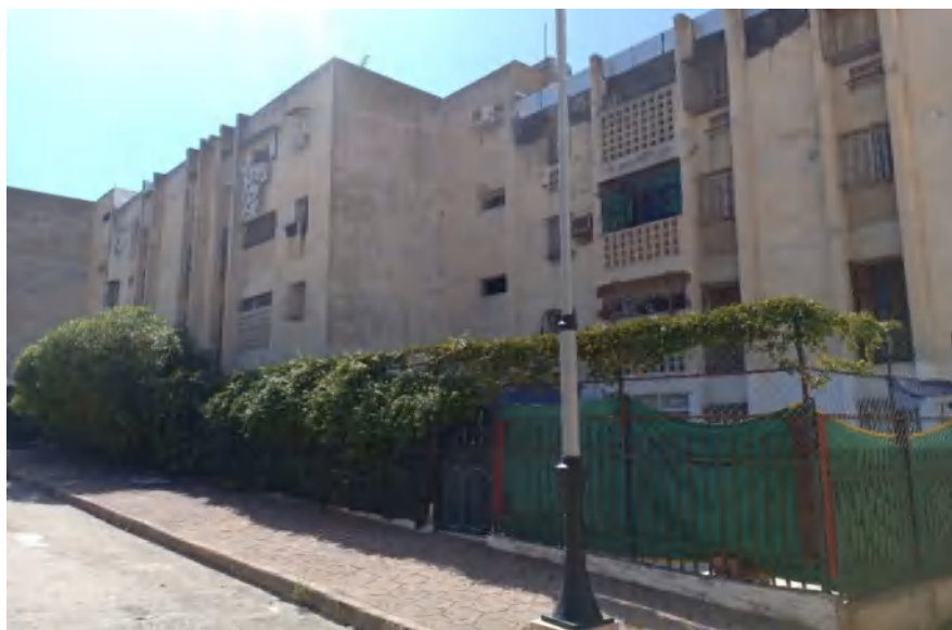
Figure 6-26: Résidentialisation spontanée du pied d'immeuble à Constantine (2019)
