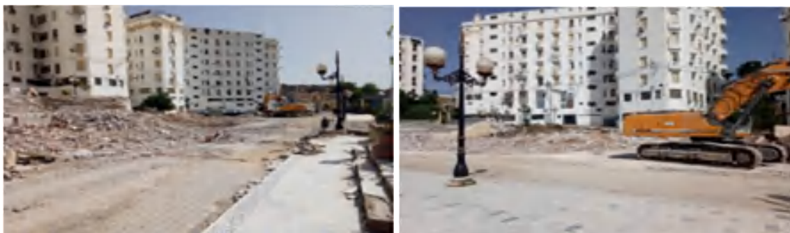
Figure 6-25: Démolition de la place et second aménagement dans le cadre de la réhabilitation de l'hôtel CIRTA
