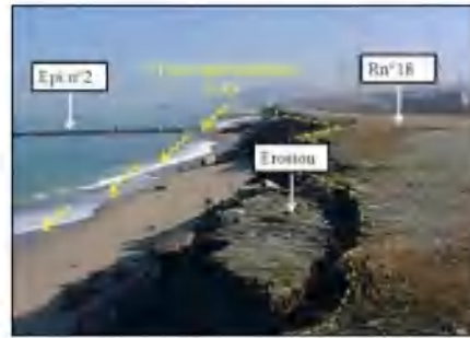
Photo.5- l'épi est un ouvrage de protection contre l'ensablement du port méthanier
