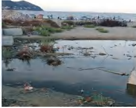
Photo 18- Rejet d'eau usée dans la plage Telezza
