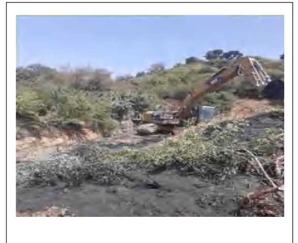
Photo 27- Curage de matériaux sédimentaires dans le lit d'un affluent du Saf-saf(2018)
