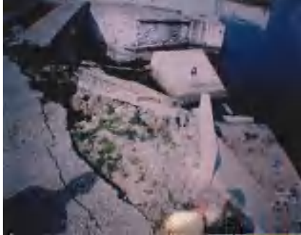
Photo 10- Les destructions causées par la tempête de 2004 dans le port commercial
