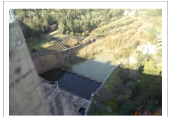
Photo 24- Le déversoir de crue de Zardazas
