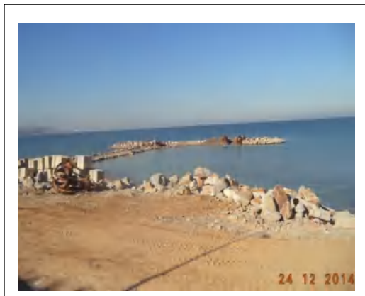
Photo 38- Construction nouvelle d'un épis pour protéger le rivage
