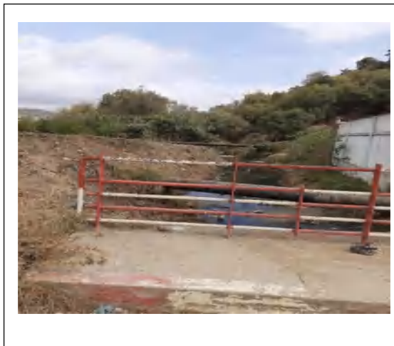
Photo 31- Aménagement sur l'un des affluents du Saf-Saf (2021)
