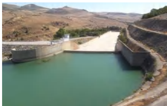
Figure 85 évacuateur de crue
