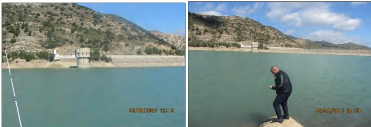
Figure 88 : (photo vue de la tour de prise d'eau (KHENICHE Soufyane 2016)
