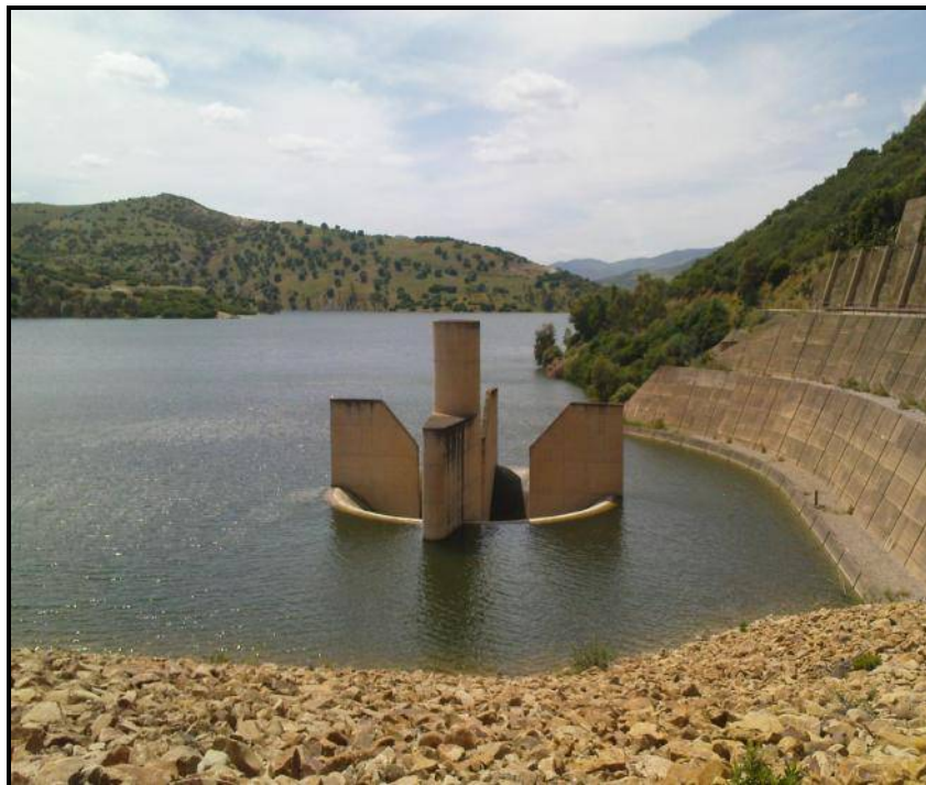
Photo 04: Le barrage de Hammam Debagh: évacuateur de crues en puits de section circulaire et protection sur la rive gauche (vue à partir de la digue) Photo : mai 2012
