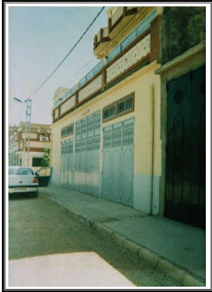
صورة رقم 02 تخصيص باب اجديد - البناء في المنطقة -
