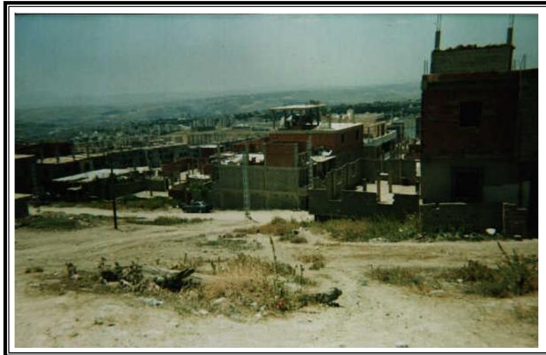
صورة رقم 06 تخصيص بليي - تداخل البناء لعدم احترام مقاييس البناء -
