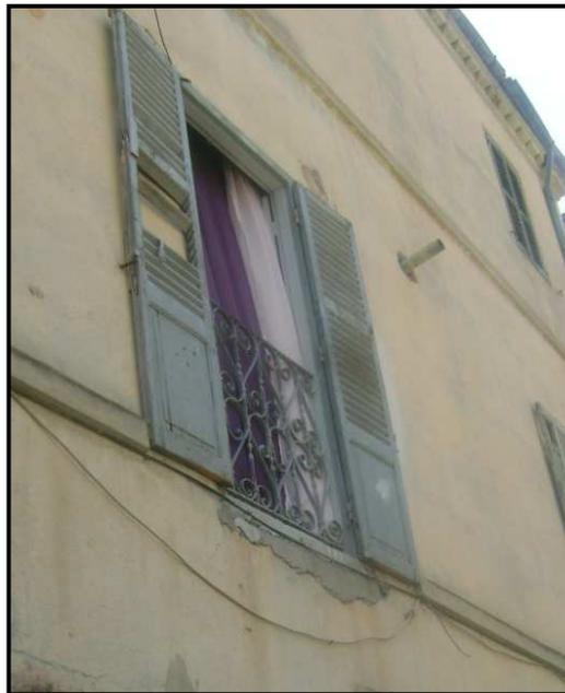
**Figure 2. 41** : Grande fenêtre avec persiennes en bois et garde corps en fer forgé. Source : auteur, 2011.
