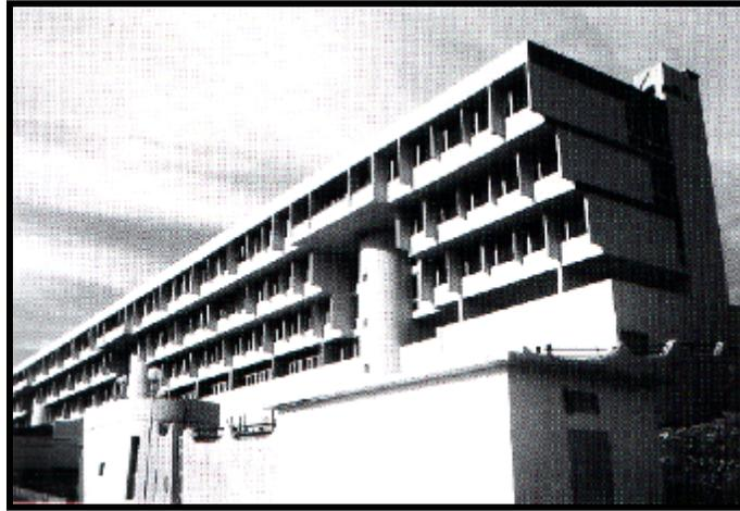
**Figure 5-41** : Exemple d'effet d'auvent ; les étages en encorbellement de la cité des étudiants de l'université de Constantine, par KENZO TANGE
