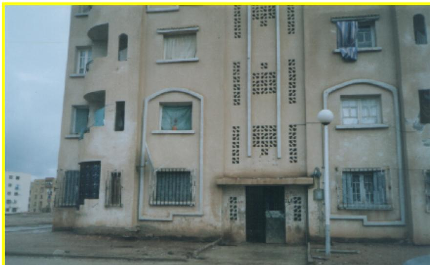
**Planche 5-6:** Elément architectural utilisé pour la façade du site d'étude de la nouvelle ville et type de protection utilisé pour se protéger des rayons solaires intenses.
