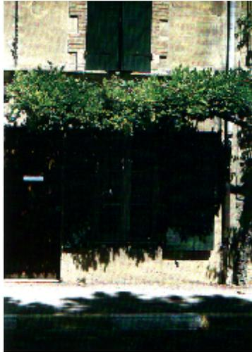
**Figure 5-30** : Réponse vernaculaire à la protection solaire avec un effet d'auvent « la treille »
