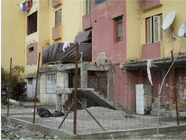
**Photo 35: Construction d'un escalier pour l'aménagement d'une entrée privative. Source : Auteur (2009)**
