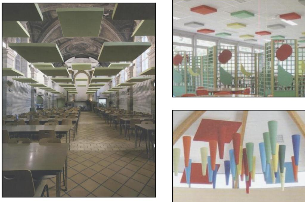
**Figure III- 7. Traitement acoustique du plafond d'une cantine scolaire en matériau absorbant**
