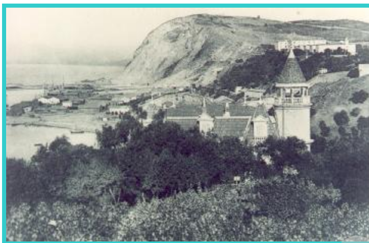
Photo n° 23 : le mont de Bouabaz (coté est) on voie clairement qu'il était un site vierge à l'époque coloniale.
