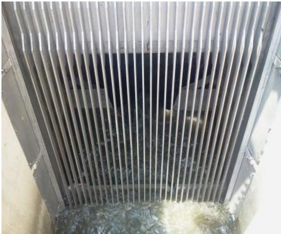
*Figure I.2. Exemple des écrans à barres.*
