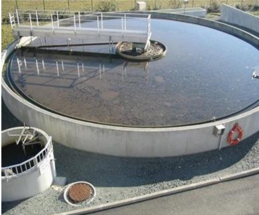
*Figure I.3. Exemple des bassins de décantation.*
