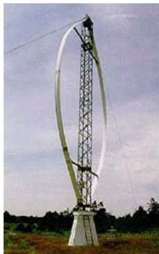
Figure 1.2 Eolienne à axe vertical [8]
