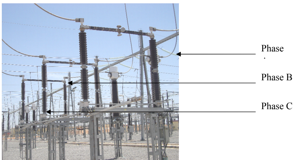
Figure I.12 - Sectionneur de ligne
