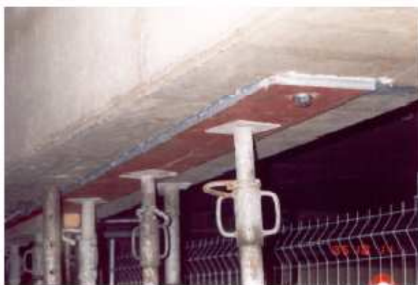
Figure II.19 : Renforcement d'une poutre par une plaque métallique .
