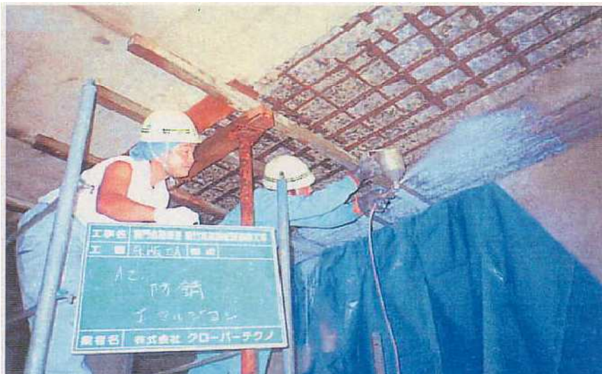
Figure II.3. Traitement des armatures avec de l'inhibiteur de rouille
