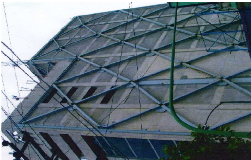
Figure II.1.Renforcement d'un immeuble par incorporation de profils en acier
