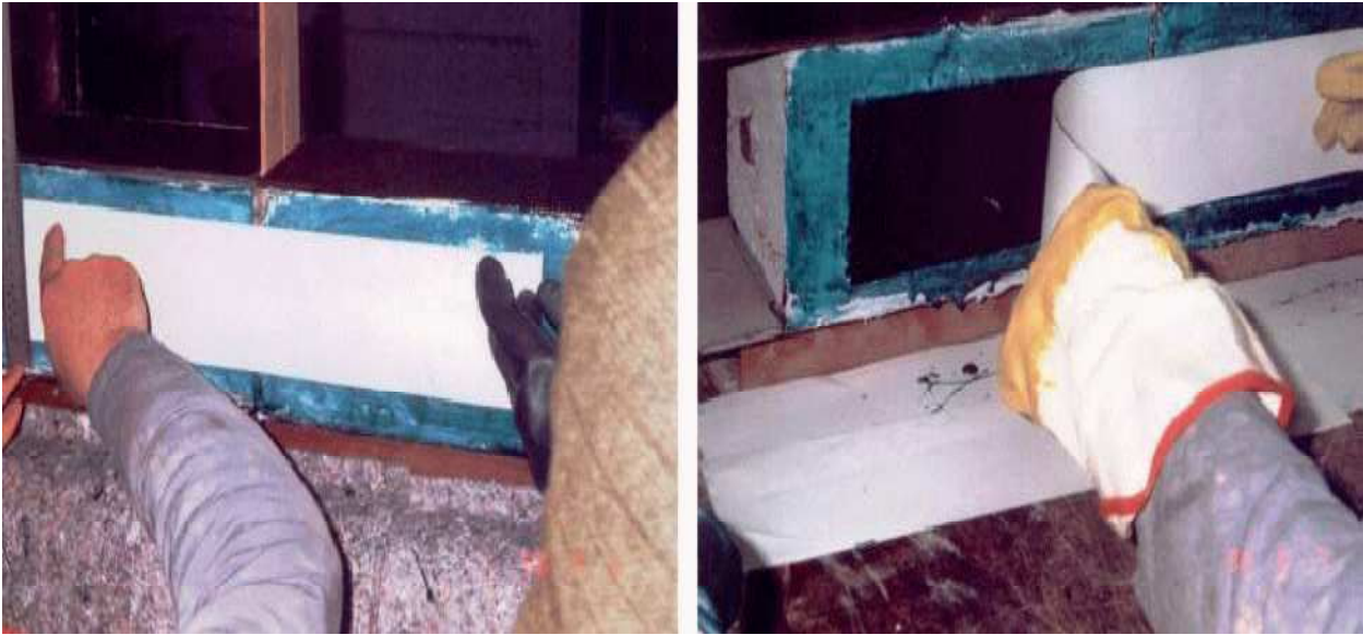
Figure II.9 : Application des lamelles de CFRP (à gauche) et enlèvement du papier de protection(à droite)
