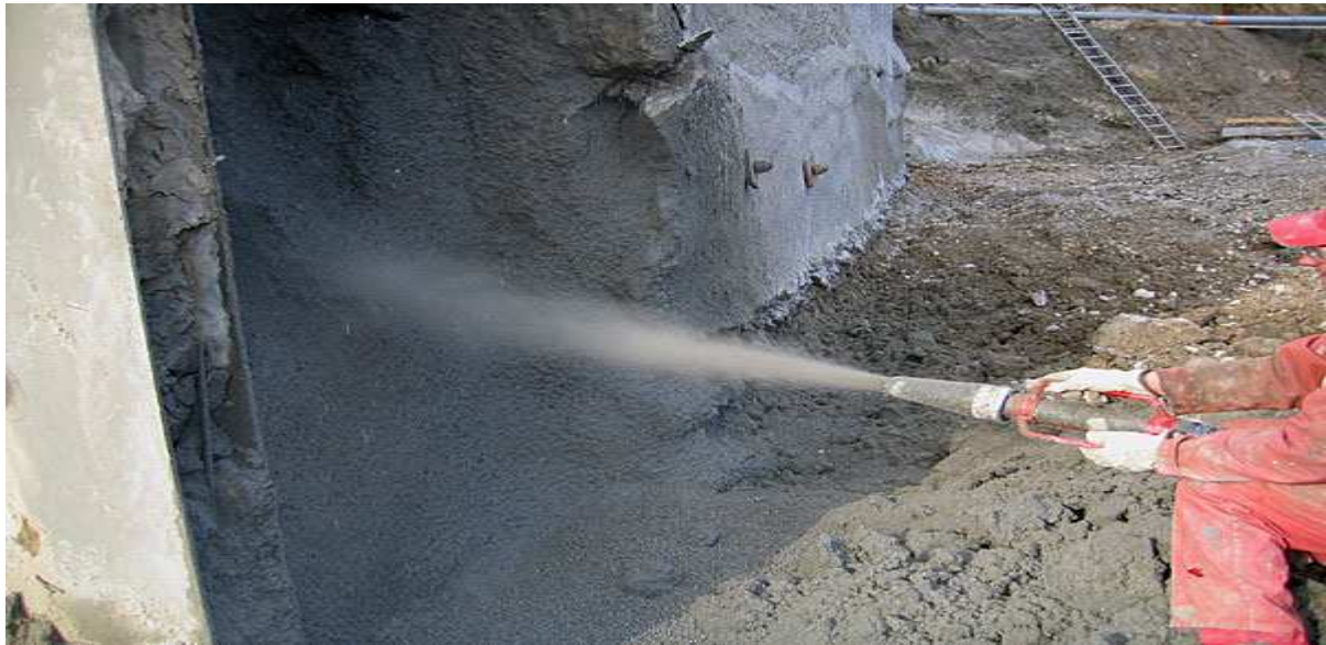
Figure II.6 : Projection du béton par voie sèche
