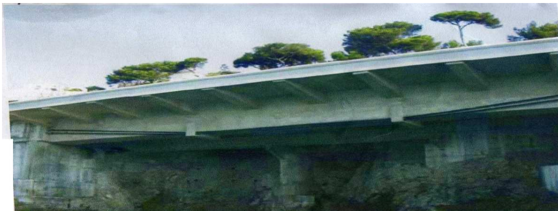
Figure II.10 : Pont renforcé par précontrainte extérieure
