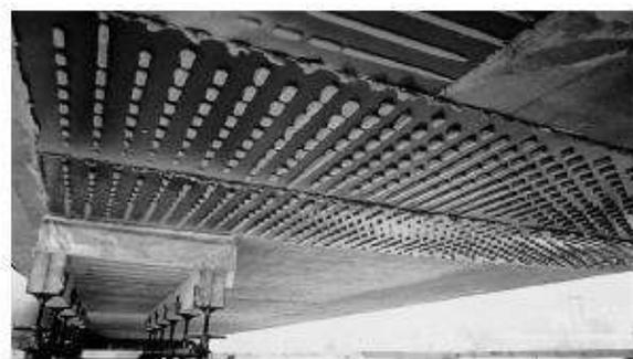
Figure 1.4. Renforcement d'un viaduc par tôles collées [2].
