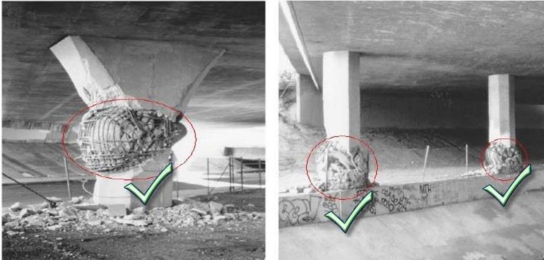
Figure 5. 12: Rotules plastiques des piles des ponts. [7]
