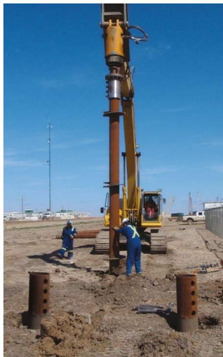
Figure 1-12. Installation des pieux hélicoïdaux à haute capacité (Cyntech - A Keller Company)
