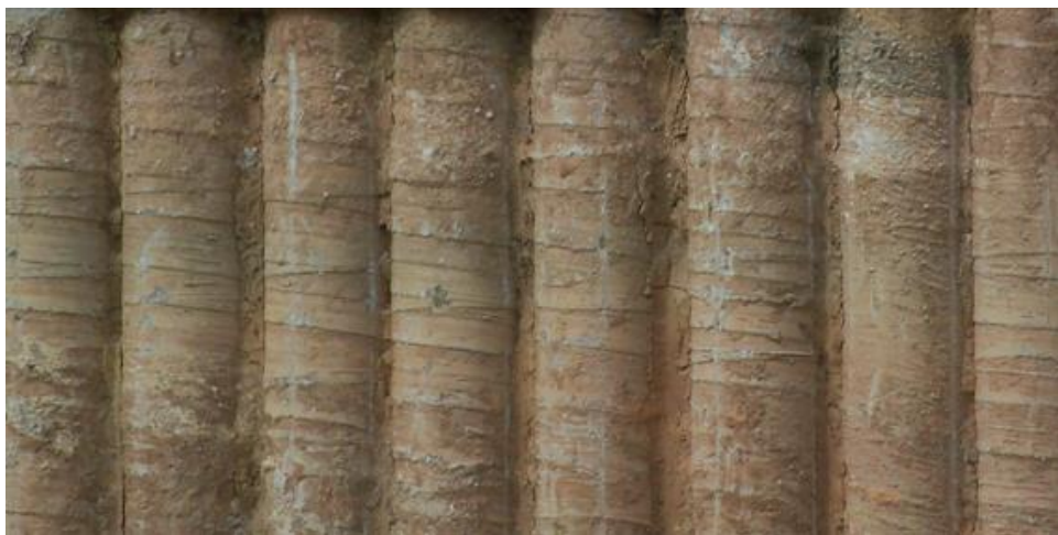
Figure 4-8. Exemple d'un mur en pieux jointifs construit pour supporter un talus au-dessus d'une construction de route
