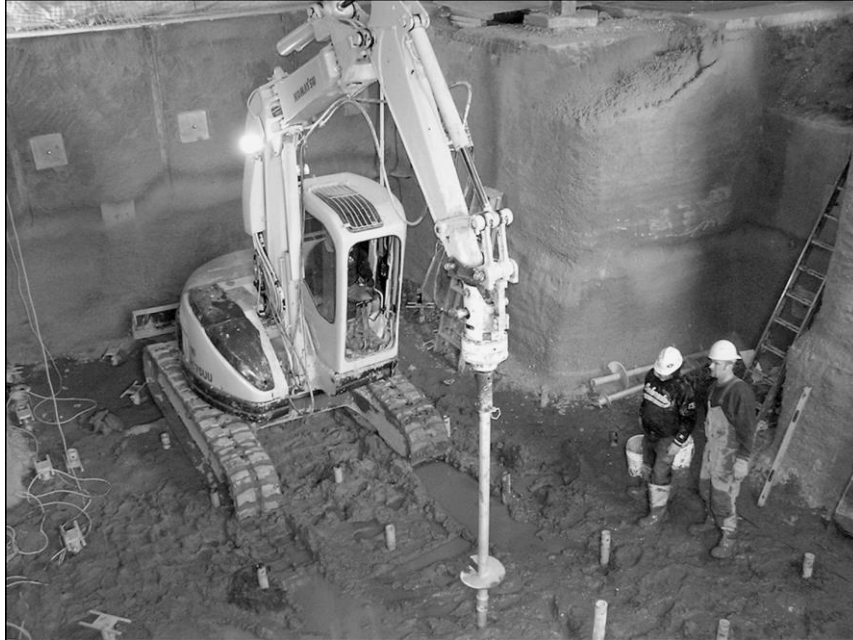
Figure 1-11. Installation des pieux hélicoïdaux ordinaires (Perko 2009)
