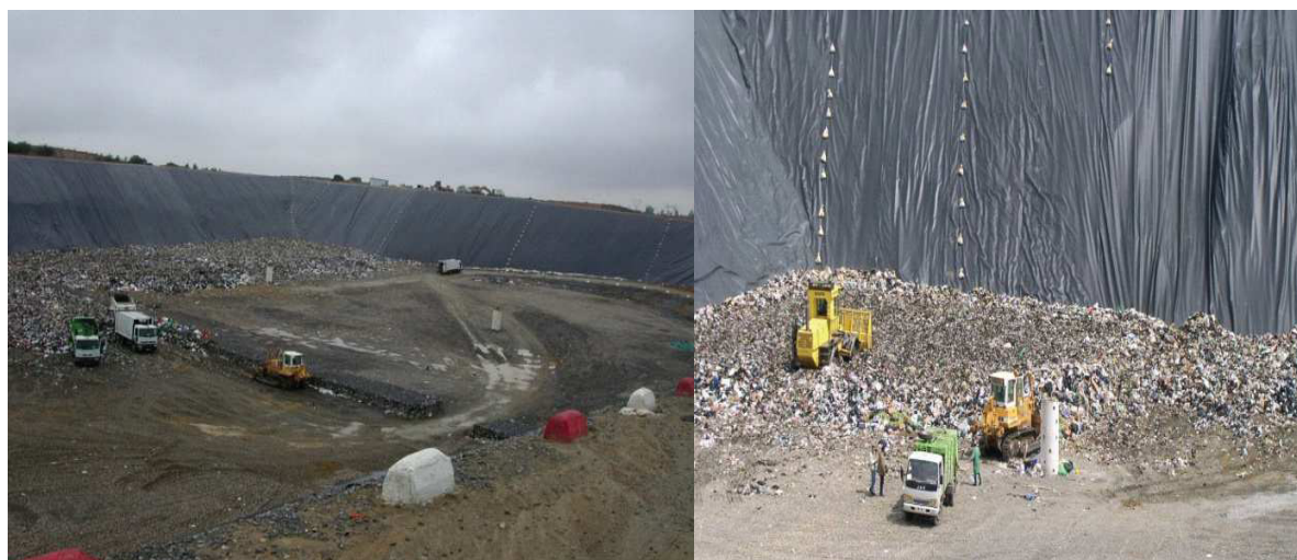
Figure 2. 1 : Centre d'enfouissement d'Ouled Fayet -Alger-(Y. KEHILA et al.2011)
