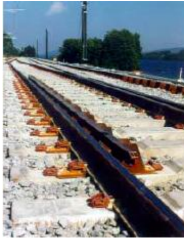
A : Rail sur Ballast
