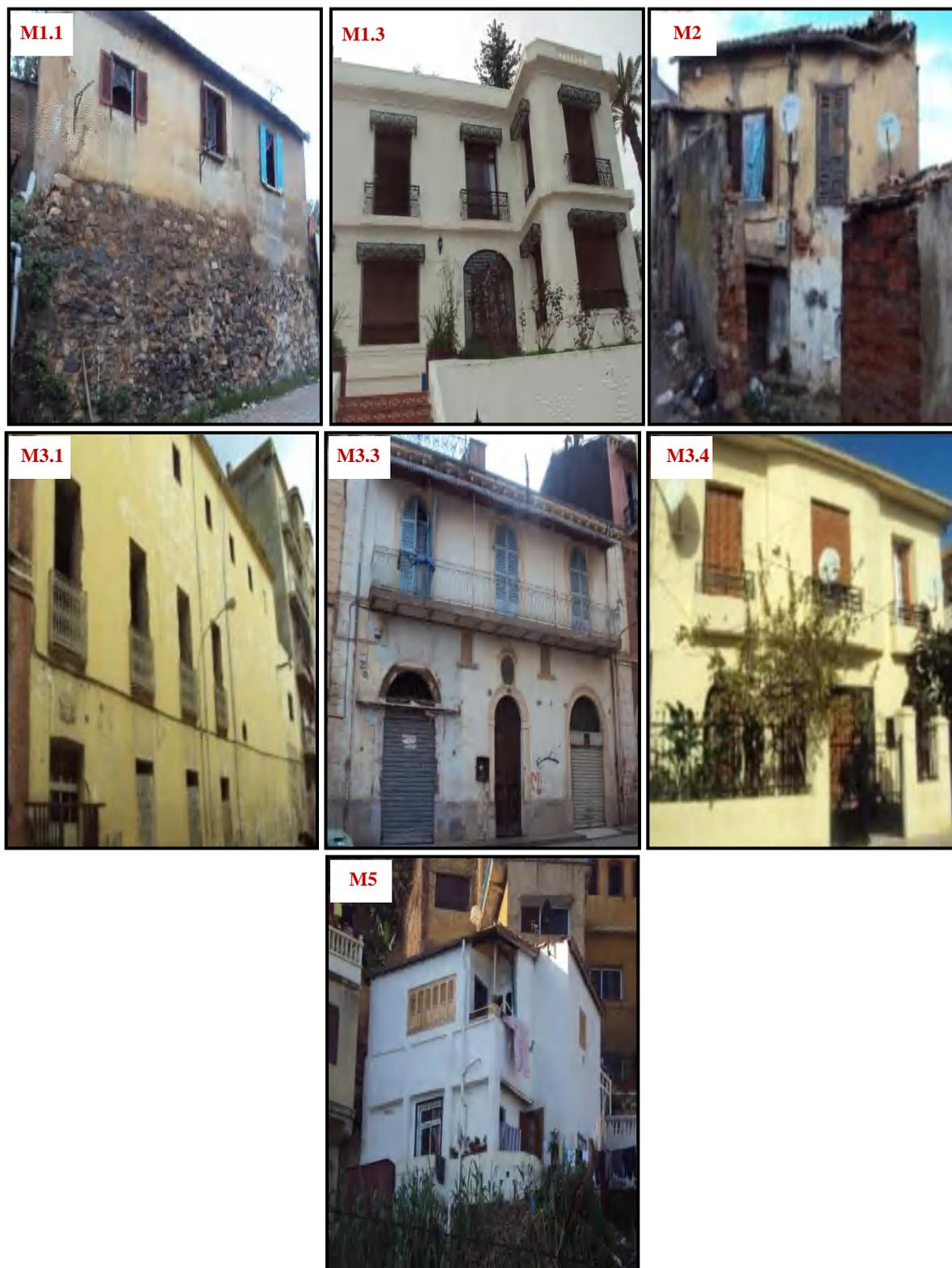
**Figure 3.6 :** Classification selon Risk-UE LM1 des constructions en maçonnerie à Skikda.
