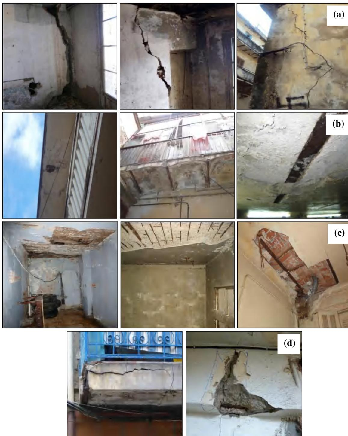
**Figure 1.27 :** Photos sur les différentes pathologies et dégradations à Skikda : a) Fissuration verticale dans la cloison, fissurations obliques au niveau des murs porteurs et fissuration verticale au niveau du mur porteur ; b) Corrosion de solive, corrosion en voûtes et corrosion des poutrelles métalliques ; c) Effondrement partiel des planchers (en bois, en béton armé et en voûtes) ; d) dégradation des balcons (CTC, 2012, Groupement CTC et AQUIDOS, 2016).
