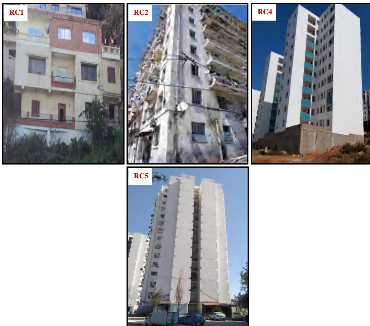
**Figure 3.7 :** Classification selon Risk-UE LM1 des constructions en béton armé à Skikda.
