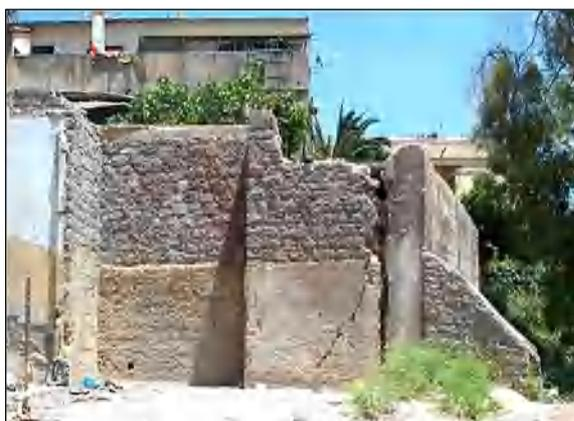
**Figure 2.32. Décollement du mur de soutènement avec des fissures en diagonale.**
