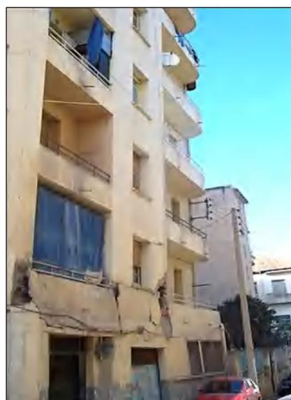
**Figure 2.33. Bellevue basculement du bâtiment avec dégradation du béton.**
