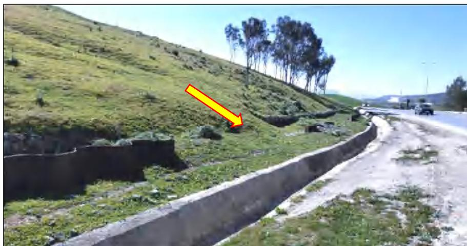
Figure 2.64. Versant instable renforcé par palplanche et gabionnage.
