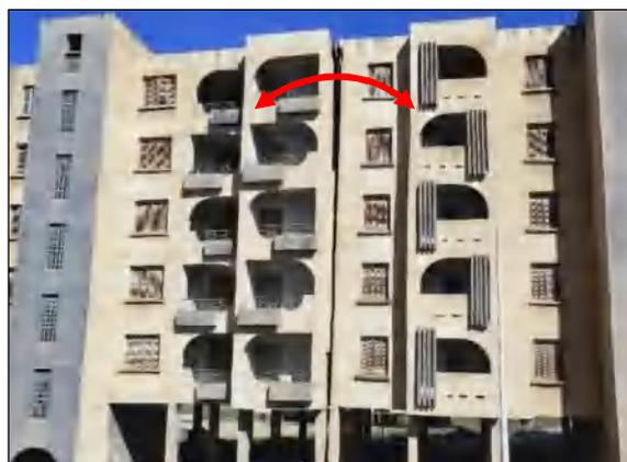
Figure 2.14. Basculement des bâtiments avec l'ouverture du joint.
