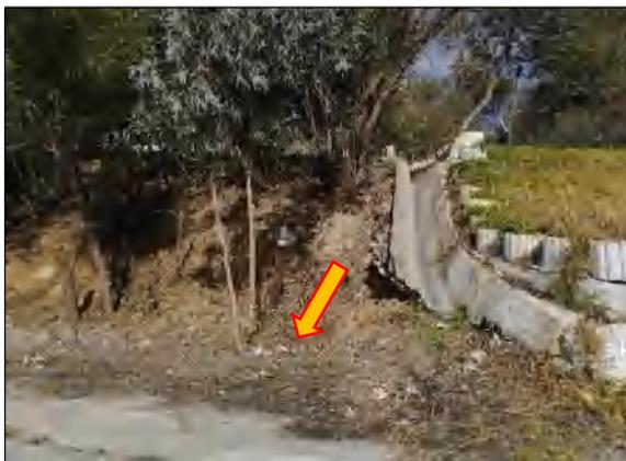
**Figure II.6. Arbres inclinés et caniveaux défectueux vers Oued Rhumel.**
