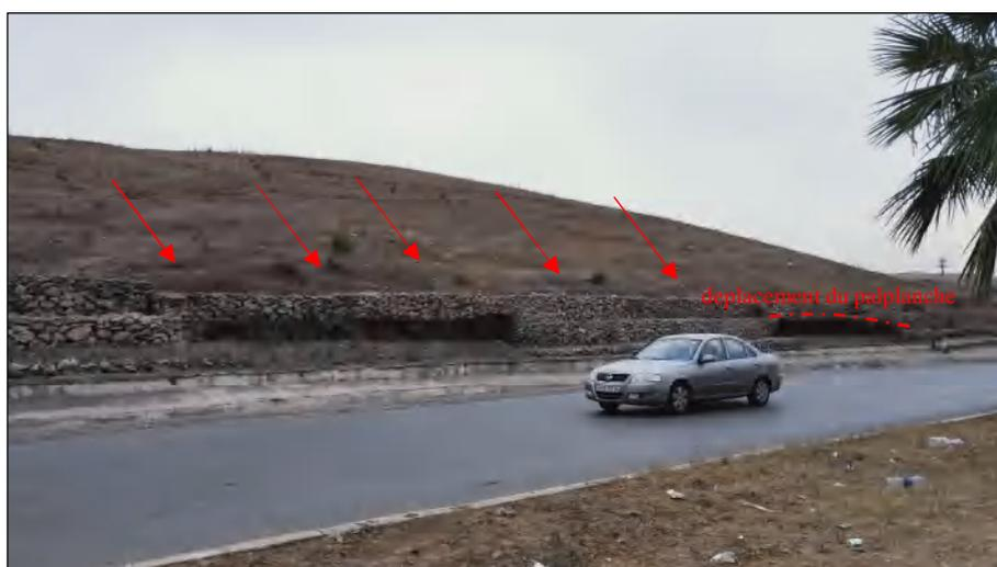
Figure 2.67. Déplacement des palplanches et du gabionnage sur l'axe routier Contournement-Sud.
