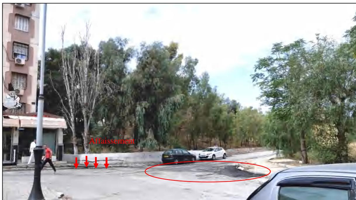
Figure 2.19. Apparition des affaissements de la voirie et remplissage par du bitume.
