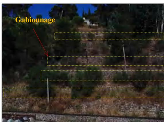
Figure 2.58. Banquette pour le talus renforcé par gabionnage (gabionnage déformé).
