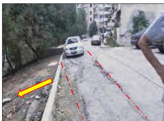
Figure 2.16. Dégradation de la route cite Boussouf.
