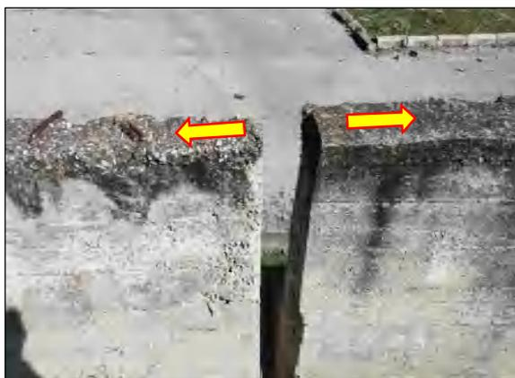
Figure 2.13. Basculement du mur de soutènement avec l'ouverture du joint.
