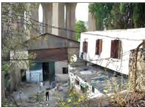
Figure 2.55. Maisons et hangars fissurés et basculés au pied de la culée du pont de Sidi Rached.
