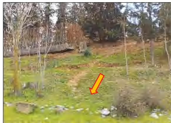
**Figure II.9. Affaissement et éboulement du talus vers Oued Bumerzoug.**
