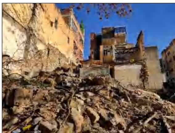
**Figure 2.45. Rupture d'une partie de la structure avec dégradation dans la partie restante de la construction.**
