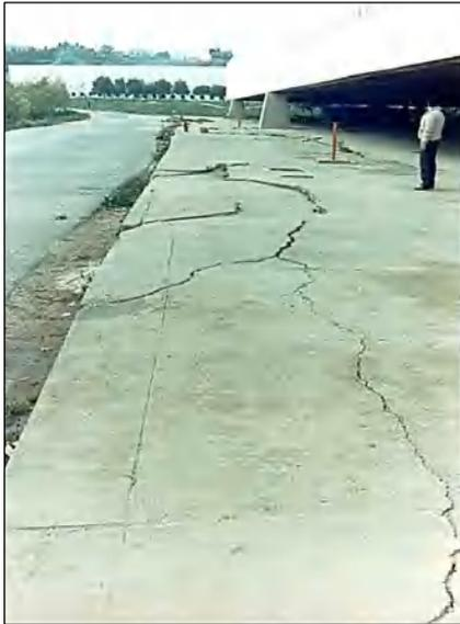
**Figure II.4. Façade Est du bloc des classes affaissement de la chaussée au niveau du remblai autour des amphithéâtres.**
