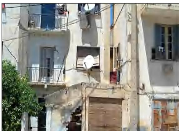
**Figure 2.34. Dégradation du béton avec des fissures diagonales dans la construction sur un talus de forte pente.**
