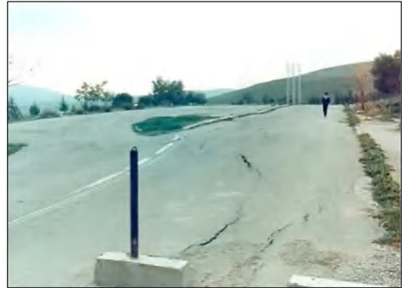
**Figure II.5. Des dégradations de la voirie et du parking coté Est du bloc des sciences.**
