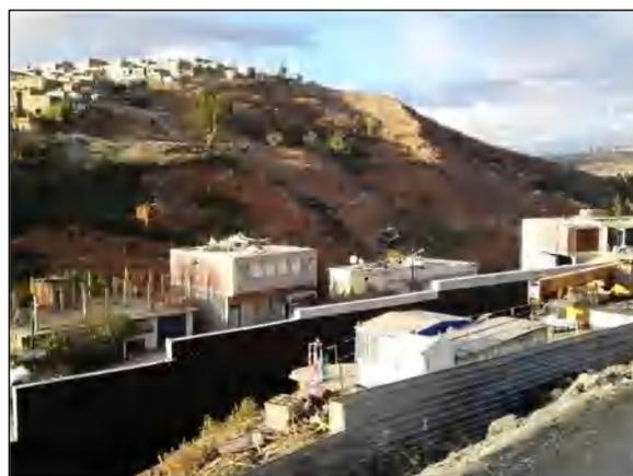
Figure 2.48. Mur de soutènement fondé sur pieux dans le site de Ben-chergui durant l'année 2013.
