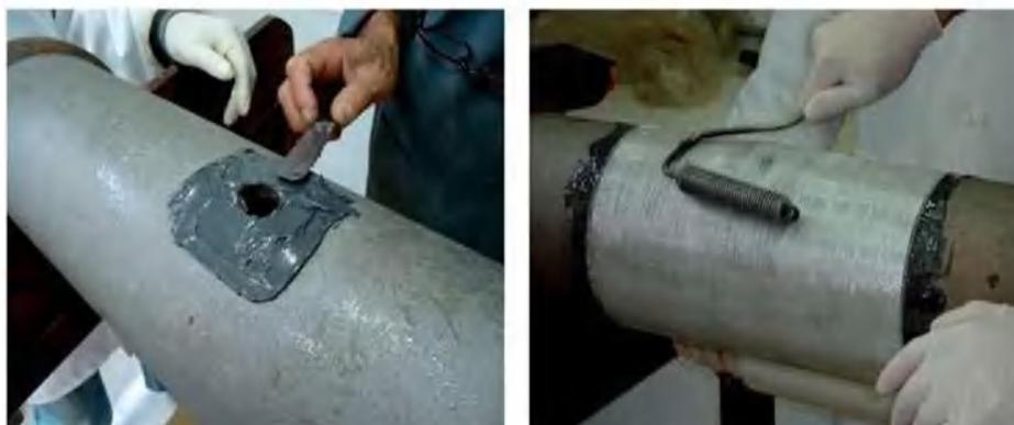
FIGURE 1.6 : Réparation par collage des pipes
