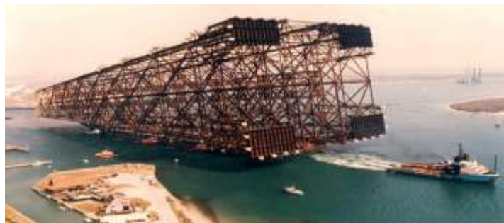
Figure. 2. Joint tubulaire KT dans une structure enveloppe (jacket) lors de la fabrication
