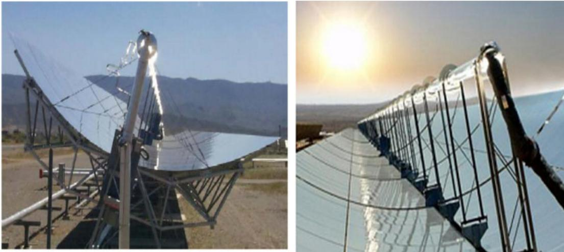
**Figure I-15:** Concentrateur solaire à ébullition directe à Almeria
