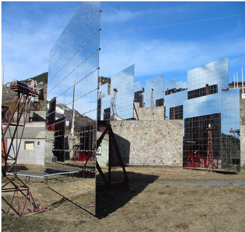
**Figure II.3.** Ensemble des miroirs formant le four.
