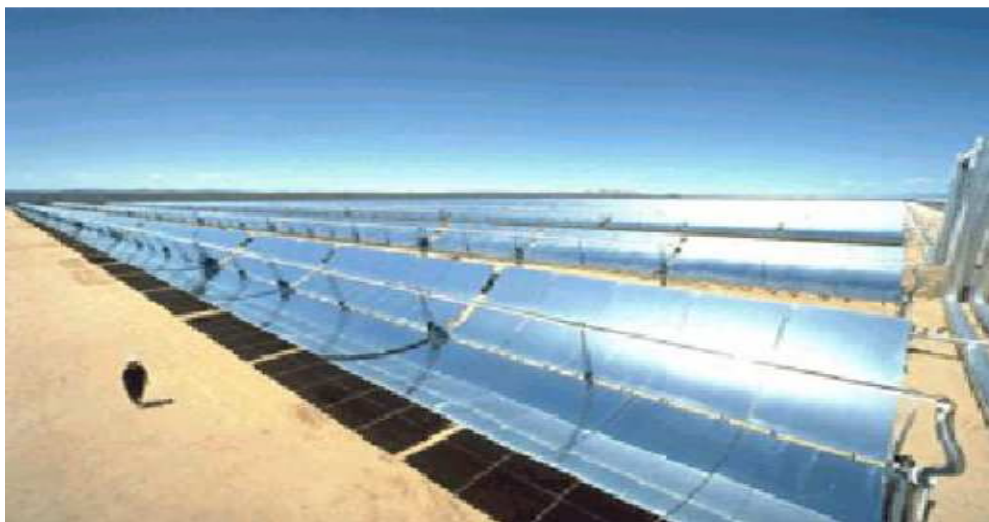
Figure 3.2 : Champ de miroir cylindro-parabolique à la centrale solaire de Kramer Junction en Californie. [62]
