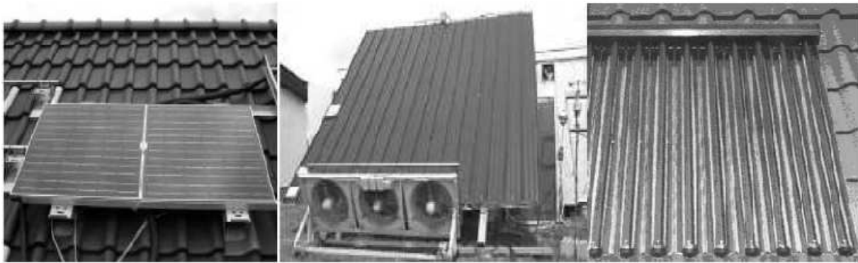
Figure 2.9: Exemple de capteurs solaires plans vitrés [19], non vitrés [20] et de capteurs solaires à tube sous-vide
