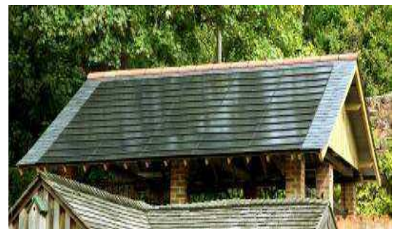
Fig.III.11. Intégration en toiture.
