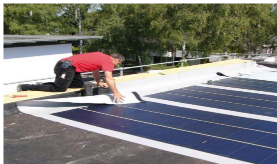
Fig.III.12. Membranes d'étanchéité PV.
