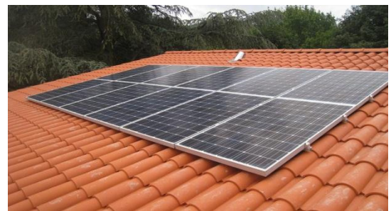
Fig.III.10. Le montage en surimposition.
