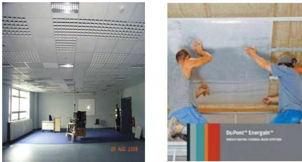
Fig.IV.7. Exemple d'intégration des MCP aux plafonds [76]
