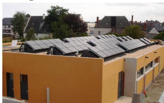
Fig.III.13. Surimposition en toit terrasse.
