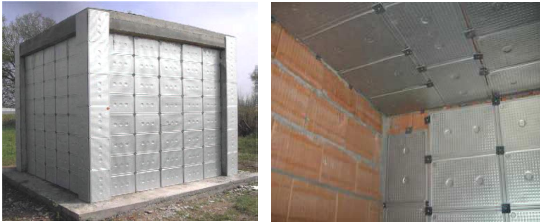
Fig.IV.5. Intégration des MCP dans les parois [76].
