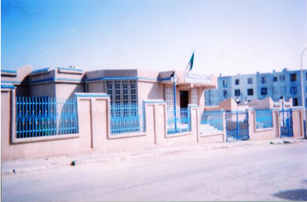
الصورة رقم ( 3 ) : تمثل عيادة متعددة الخدمات بحى بوالصوف
