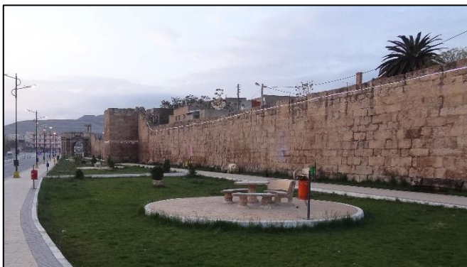
Figure 2. 2 : Vue sur la muraille Byzantine (façade Nord)
