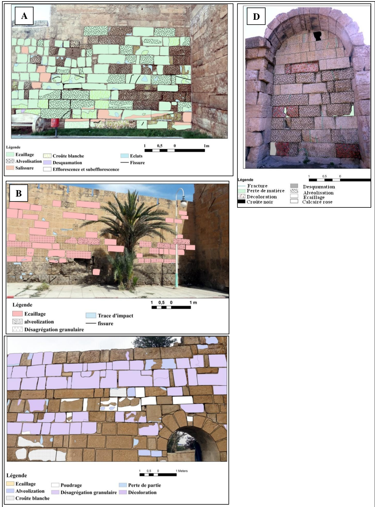
Planche 5. 2 : Cartographie des formes d'altération dans différentes façades de la muraille de Tébessa face Nord (A) Est (B) Sud (C) et au niveau de la Basilique (D)
