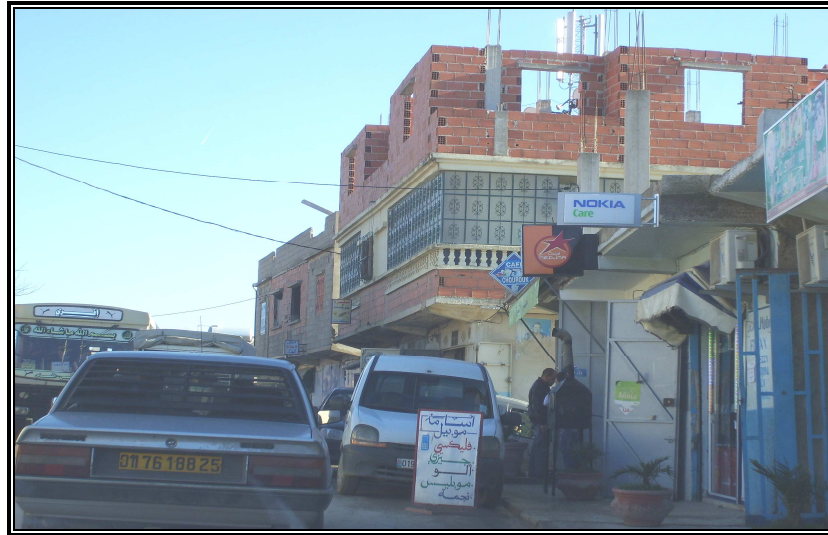
Photo n° 9 : Les commerces au rez de chaussée des habitations
