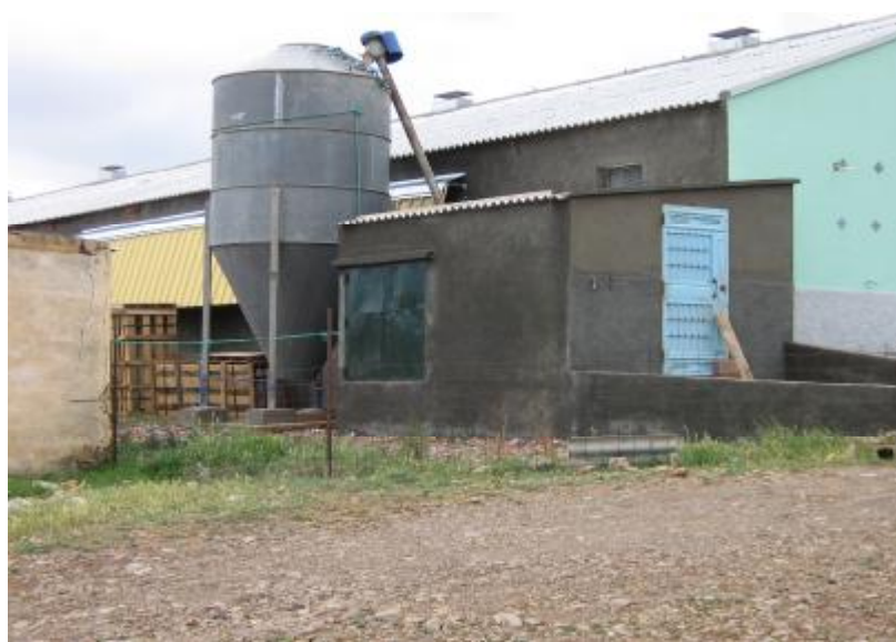
Figure n°10 : Bâtiment du lot3, agréé sous le numéro 05/19/02/1981 D'une capacité de 5000 sujets, situé dans la région de Timgad Batna
