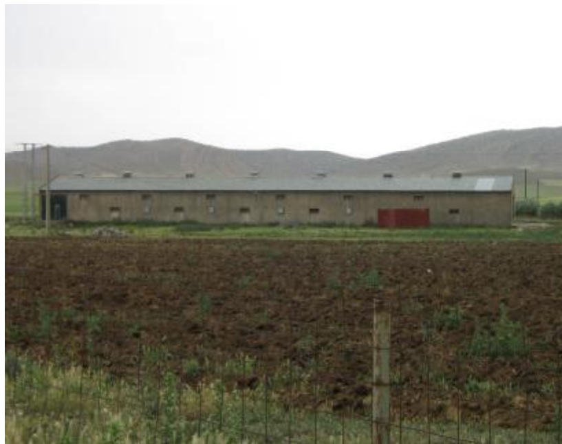
Figure n°08 : Bâtiment du lot1, agréé sous le numéro 05/09/12/1999 D'une capacité de 5000 sujets, situé dans la région de Aïoun Al-Assfir-Batna
